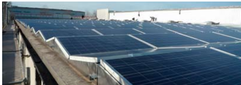
Vista tetto con lamiere laterali
